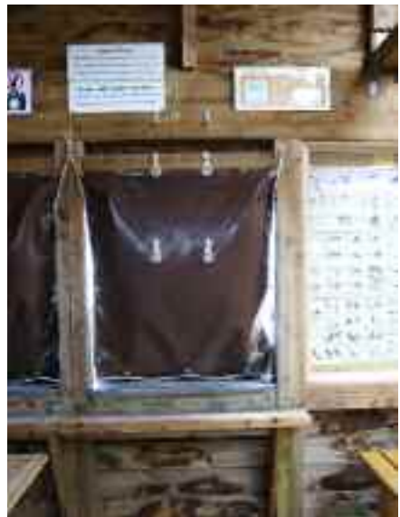
Höhenverstellbare Sichtlukenvariante am Tister Bauernmoor
