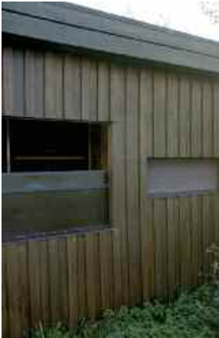
Sichtluken, die optimal anpassbar oder oder völlig zu schließen sind
