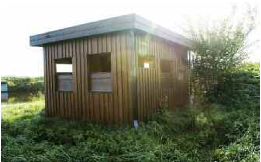
Beobachtungshütte in Wedel: In der Höhe verstellbare Sichtluken, geschützter Eingangsbereich
